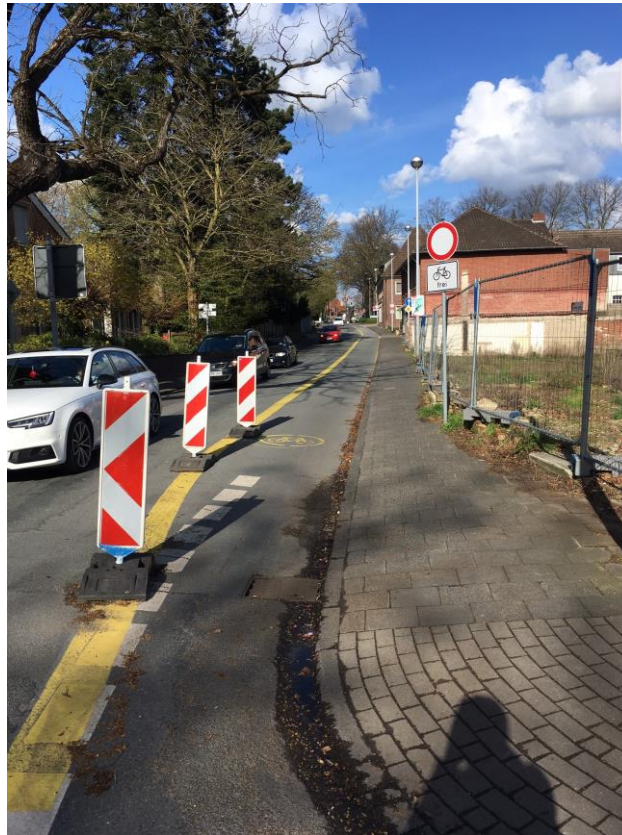
Abbildung 2-9: Markierung des Radfahrstreifens entgegen der Einbahnstraßenregelung für den motorisierten Verkehr in der Kardinal-von-Galen-Straße im zweiten Teil des Verkehrsversuchs
