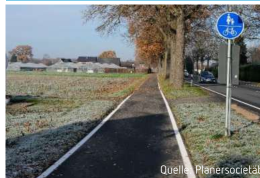
Abbildung 58: Reflektierende Randmarkierung
